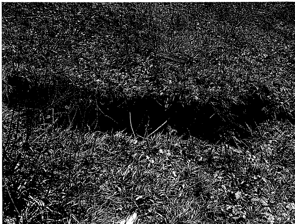
Foto 14: Particolare di una frattura aperta presente lungo il pendio in frana (aprile 2013)
