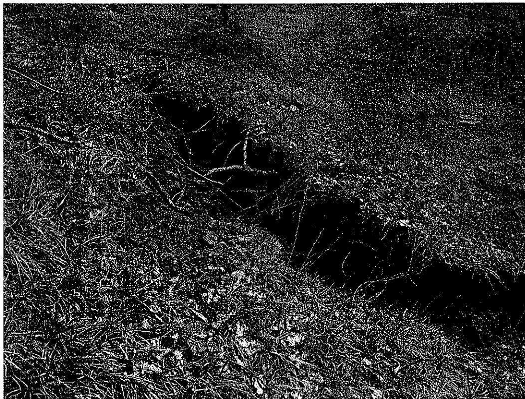
Foto 13: Vista di una delle fratture interessanti il corpo di frana (aprile 2013)
